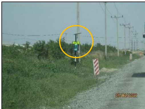
รูปที่ 2-11 ป้ายเตือนลดความเร็ว ป้ายจำกัดความเร็วไม่เกิน 30 กิโลเมตรต่อชั่วโมง ในพื้นที่ก่อสร้าง และเนินชะลอความเร็วพาหนะก่อนเข้าโครงการ
