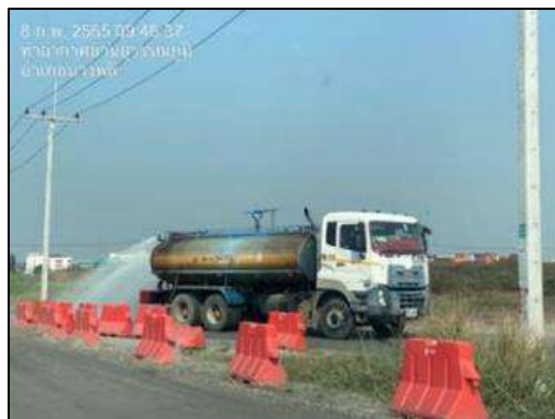
รูปที่ 2-7 การฉีดพรมน้ำในพื้นที่ก่อสร้าง
