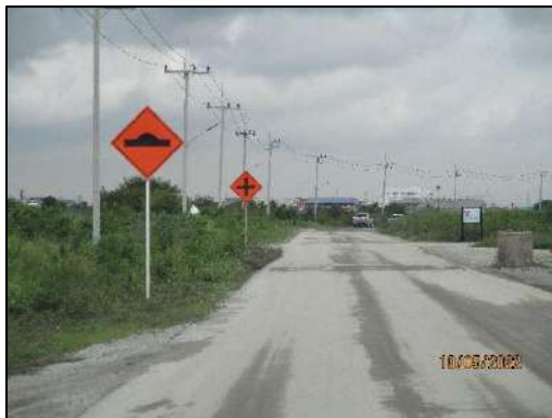
รูปที่ 2-20 การติดตั้งป้ายและเครื่องหมายทางจราจรชั่วคราวในบริเวณพื้นที่ก่อสร้าง
