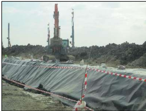
ก. แนวคันดินและการใช้วัสดุกันตามแนวทางระบายน้ำที่อยู่ใกล้พื้นที่ก่อสร้าง
