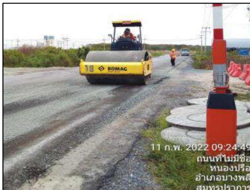
รูปที่ 2-21 ตัวอย่างการซ่อมแซมถนนทางเข้า-ออกพื้นที่โครงการฯ
