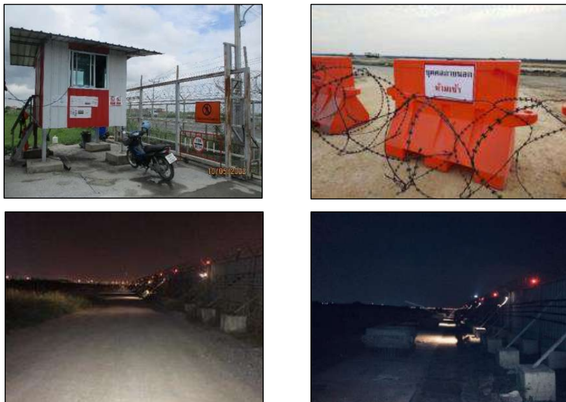
รูปที่ 2-19 ติดตั้งป้ายแสดงเขตก่อสร้าง ป้ายเตือนอันตราย และสัญญาณเตือนชั่วคราว (ไฟกระพริบ) ในจุดที่เห็นได้ชัด
