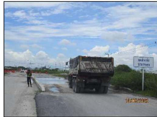
รูปที่ 2-9 ป่อล้างล้อรถก่อนออกจากพื้นที่โครงการฯ
