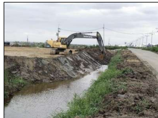
ข. การขุดลอกทางระบายน้ำในพื้นที่ก่อสร้าง
