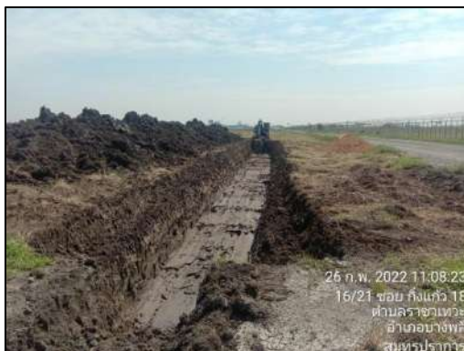
ก. แนวคันดินและการใช้วัสดุกันตามแนวทางระบายน้ำที่อยู่ใกล้พื้นที่ก่อสร้าง
