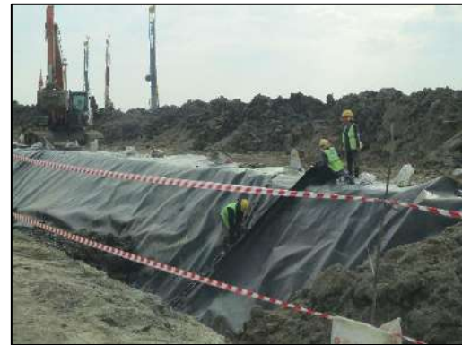
ก. แนวคันดินและการใช้วัสดุกันตามแนวทางระบายน้ำที่อยู่ใกล้พื้นที่ก่อสร้าง
