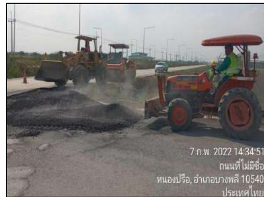
รูปที่ 2-21 ตัวอย่างการซ่อมแซมถนนทางเข้า-ออกพื้นที่โครงการฯ
